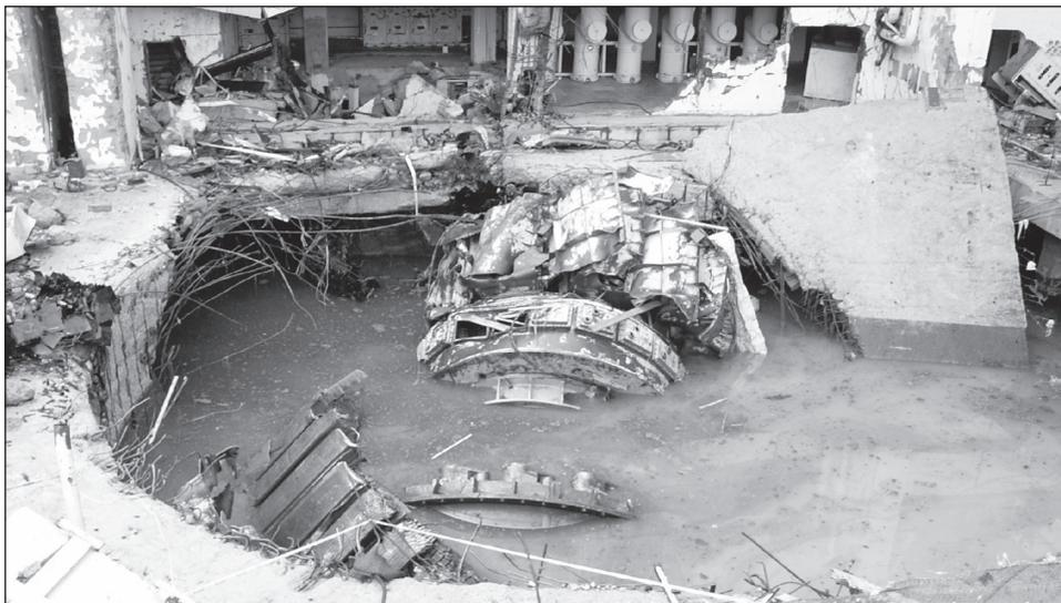
Рис. 5. Вид агрегата ГА-2 сразу после аварии до откачки воды
